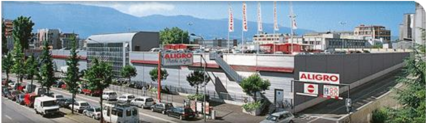
Photo du parking aérien du supermarché ALIGRO
